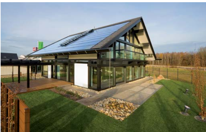
Ein elegant integriertes und üppig dimensioniertes Solardach hilft der Energiebilanz
