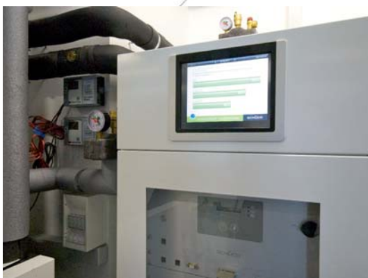
Ein Energiespeicher von Schüco puffert den Solarstrom des Energiedaches
