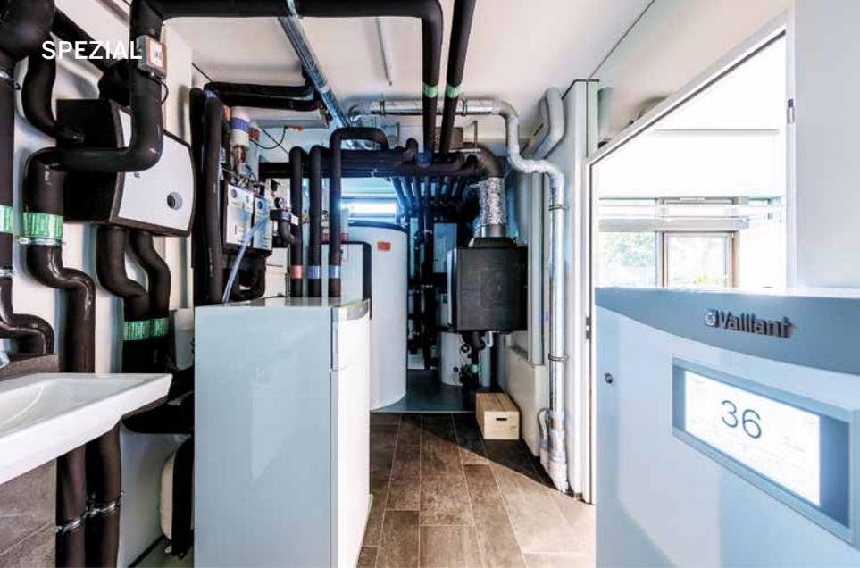
Technikzentrale: vorn links die Wärmepumpe, dahinter der Trinkwasserspeicher. Vorn rechts die Batterie, im schwarzen Kasten dahinter die Abluftabsaugung mit Wärmerückgewinnung.
