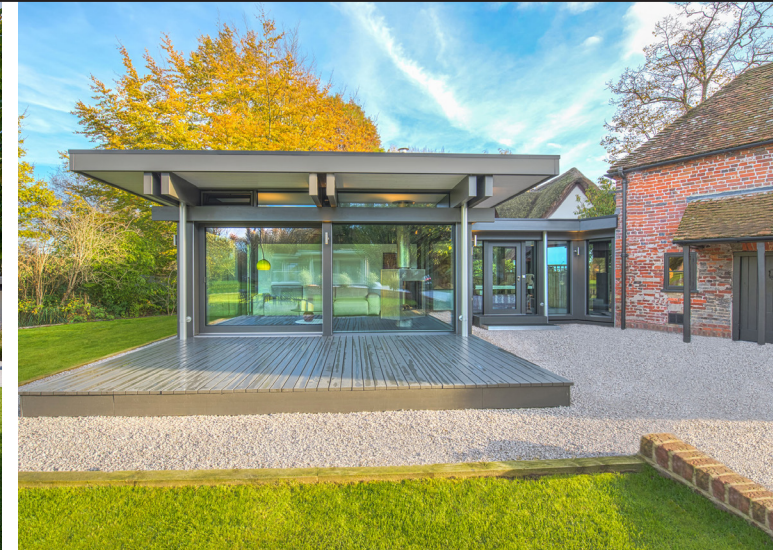
Flachdach-Anbau an ein denkmalgeschütztes Gebäude
